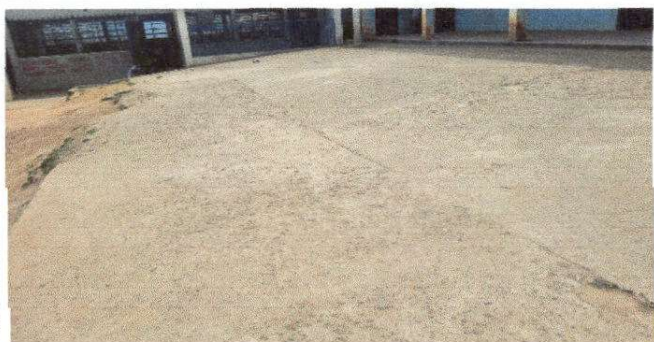
Foto 3: Sustitución de piso de torta de concreto
