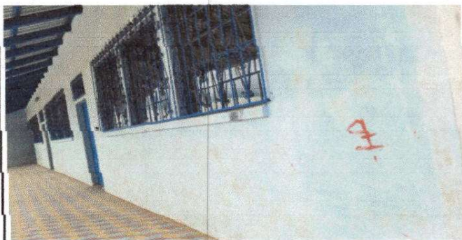
Foto 2: Pintura en muros exteriores e interiores
